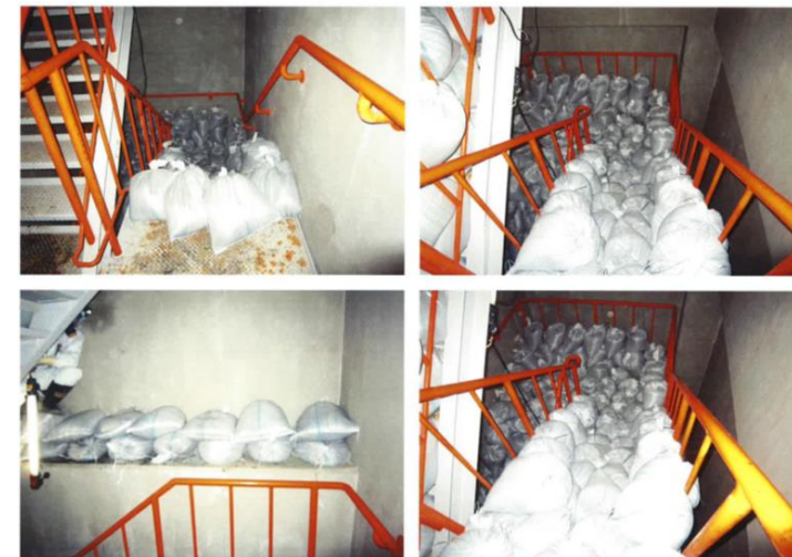
活性炭の状況（設置時）
