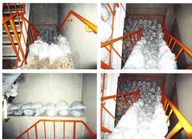
図 1.1.1-1 階段室土嚢設置状況（2011年設置時撮影）
