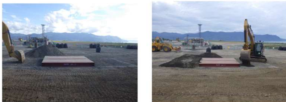
第10図 段差復旧状況
