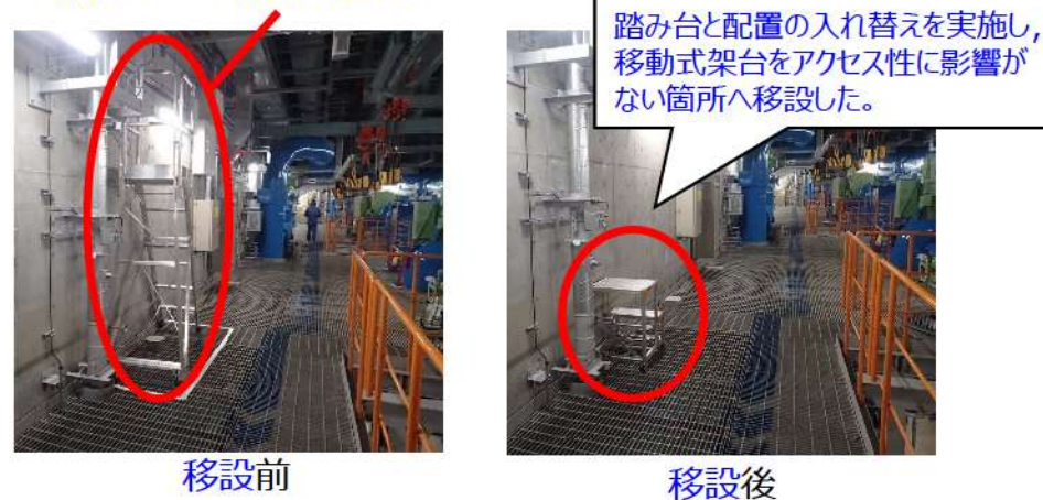
図9-2 資機材移設処置の状況
