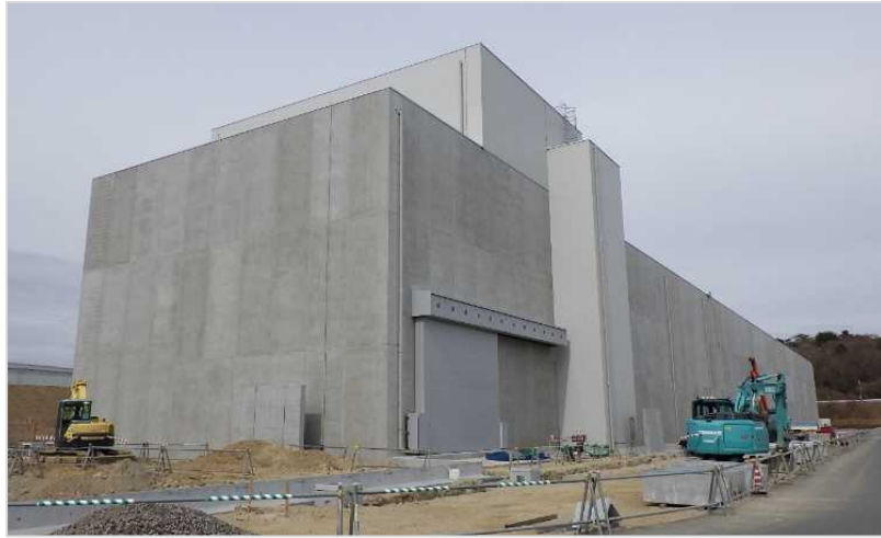
图 1-2 大型廃棄物保管庫全景（2023 年 2 月時点）
