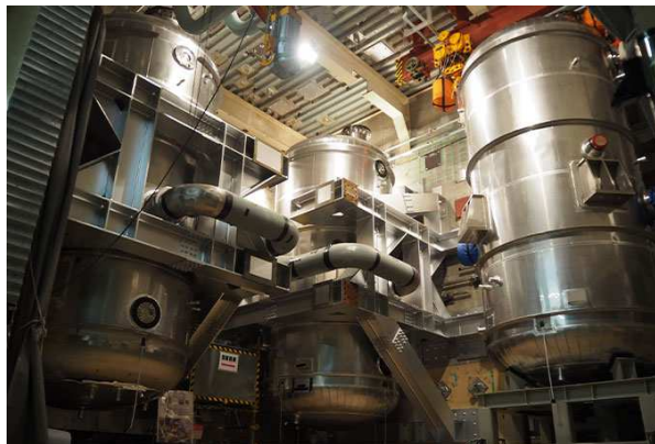
原子炉建屋への据付状況
