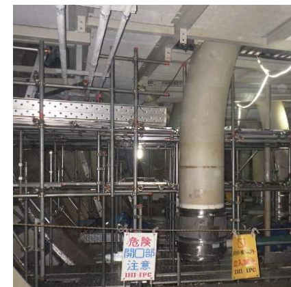
内部の工事状況
