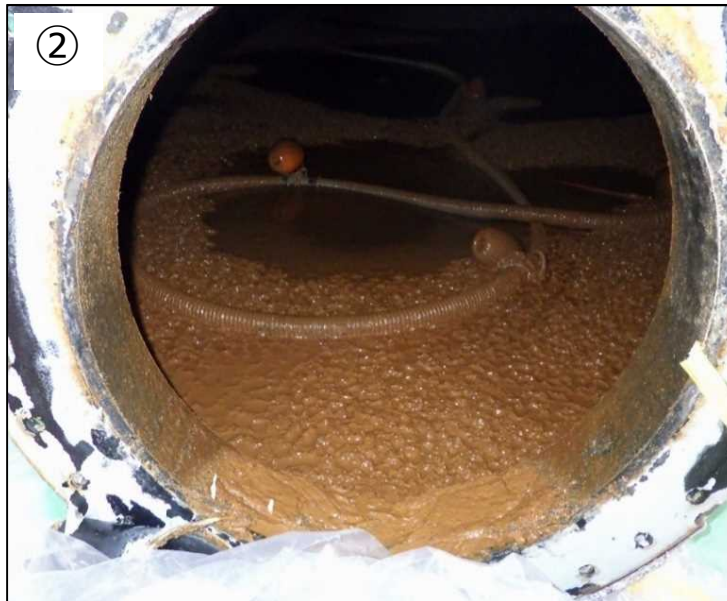
側板マンホールから内部撮影
