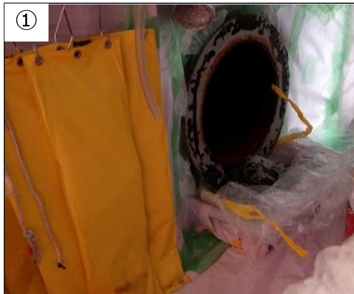
側板マンホール解放状況
