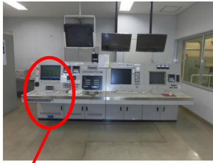
\beta ・ \gamma 焼却装置の監視盤
