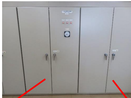
\beta ・ \gamma 焼却装置の制御盤
