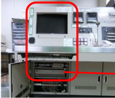
監視盤内の電子計算機（含む監視用モニタ）
