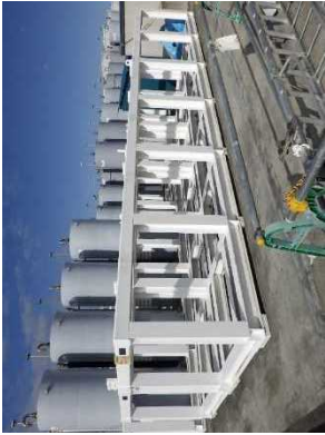
(13) 吸着塔架台(4m幅)
