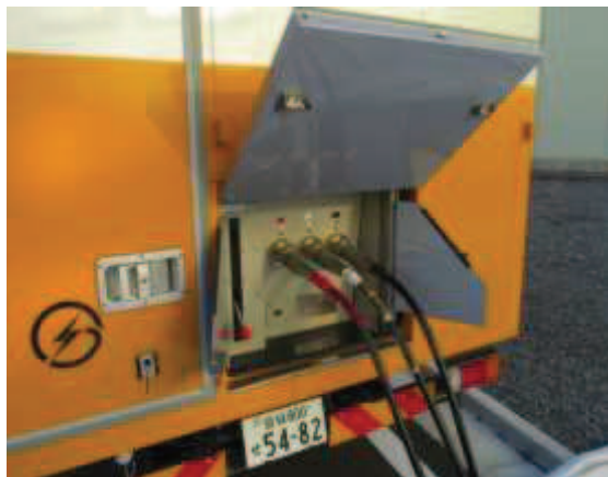
電源車ケーブル接続
