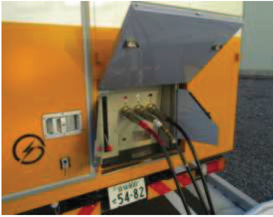
電源車ケーブル接続
