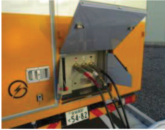
電源車ケーブル接続
