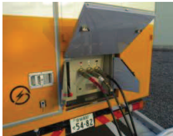
電源車ケーブル接続
