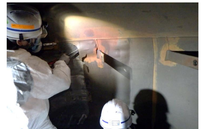
ライニング剥離作業 (スクレイパー)
