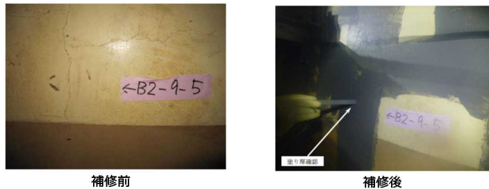
プロセス主建屋のひび割れ補修状況
