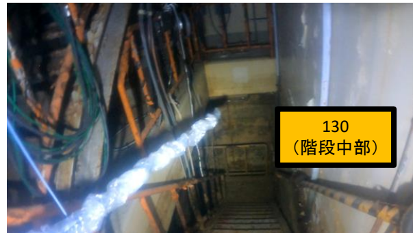
中地下階～地下階への階段 (2022年11月30日原子力規制庁撮影)
