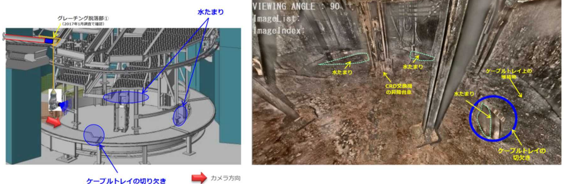
図 2.1-2 2018 年の原子炉格納容器内部調査で確認した堆積状態
