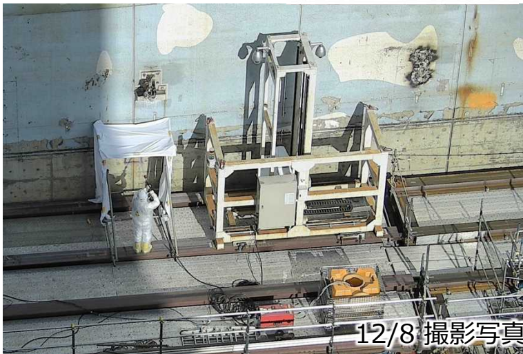
高圧洗浄の状況
