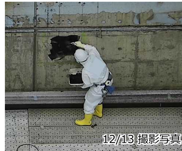
剥離除染剤塗布の状況
