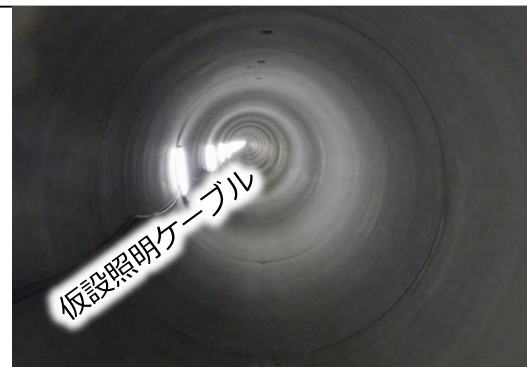
排水路推進トンネル完成状況
