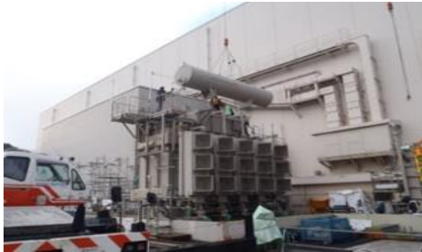
撤去作業の状況
