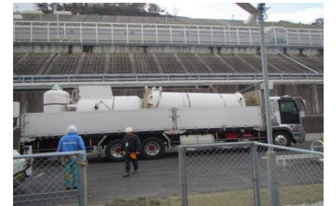
解体物の移送
