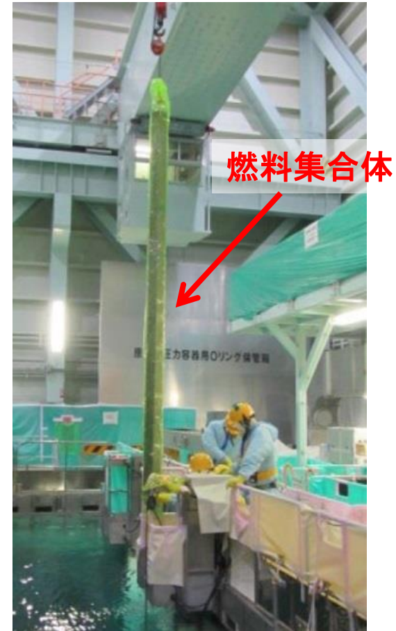
新燃料の引き上げ状況
