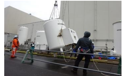
撤去作業の状況
