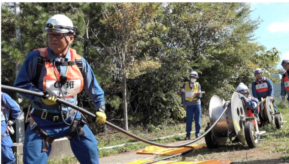
①6kV ケーブル 布設 (ケーブルドラムより引き出し)
