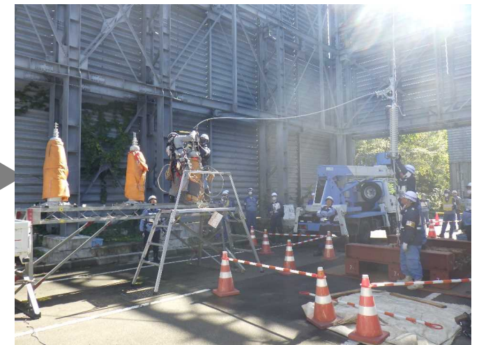
CH接続準備 (送電線余長確認)
