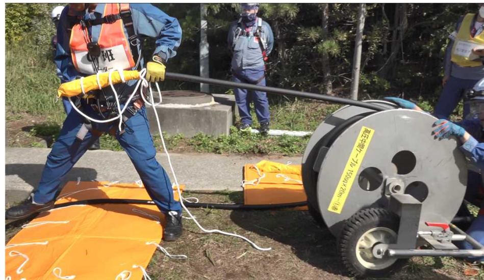
①6kV ケーブル 布設 (ケーブルドラムより引き出し)
