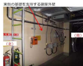
東側の基礎を支持する建屋外壁
