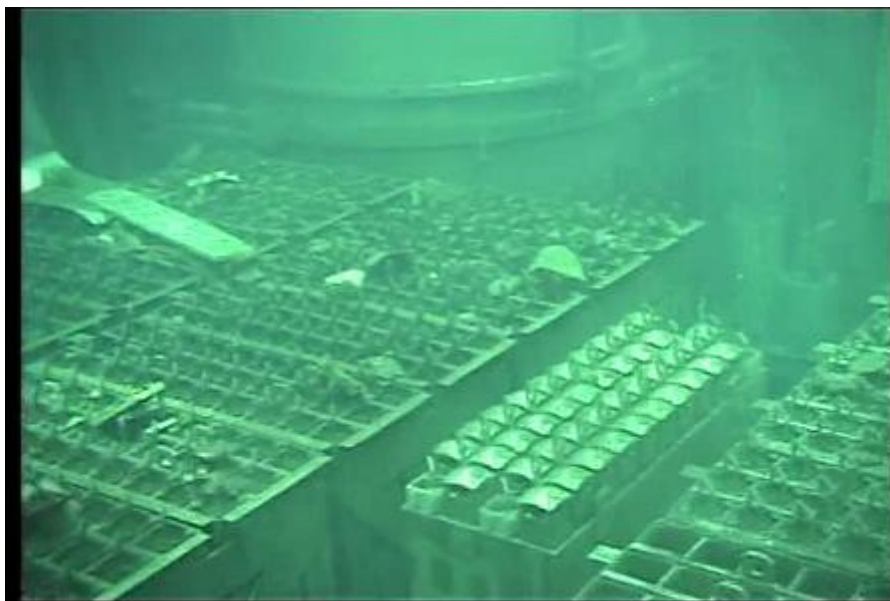
図6-1 4号機SFP内の状況（その1）
