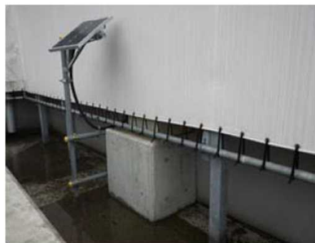
内堰外側に設置時
