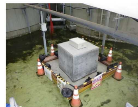
内堰基礎部に設置後
