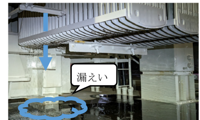
図4 現場写真(下部)
