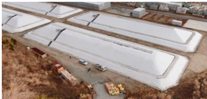
図 1.1-2 覆土式一時保管施設（一時保管エリア L）
