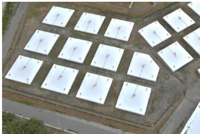
図 1.1-1 伐採木一時保管槽（一時保管エリア G）
