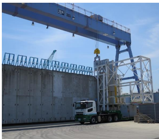
(第三施設北面 吊上げシャフト外観)
