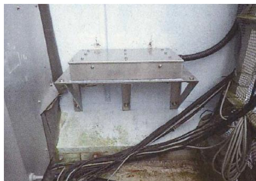
地震計設置イメージ （2号機5階）
