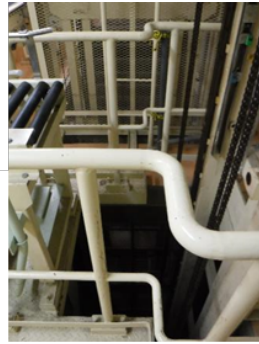
床（カートン搬出リフトの開口部）
