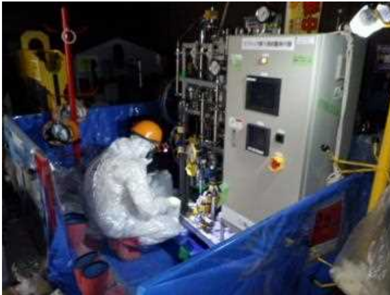
フィルタ通水試験装置写真
