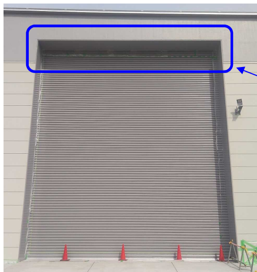
建屋南西 重量シャッター (建屋外より撮影) (幅9.4m×高さ10.8m)
