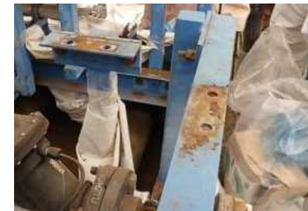
サポート部（配管取外後）
