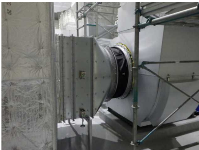
既存保温材取り外し (10/9)
