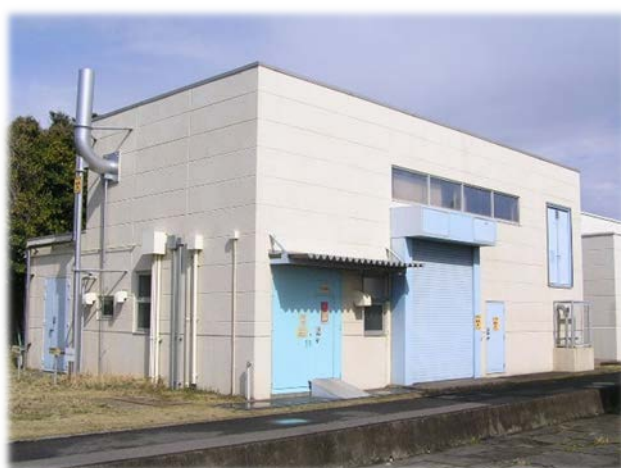
廃水処理室外観
