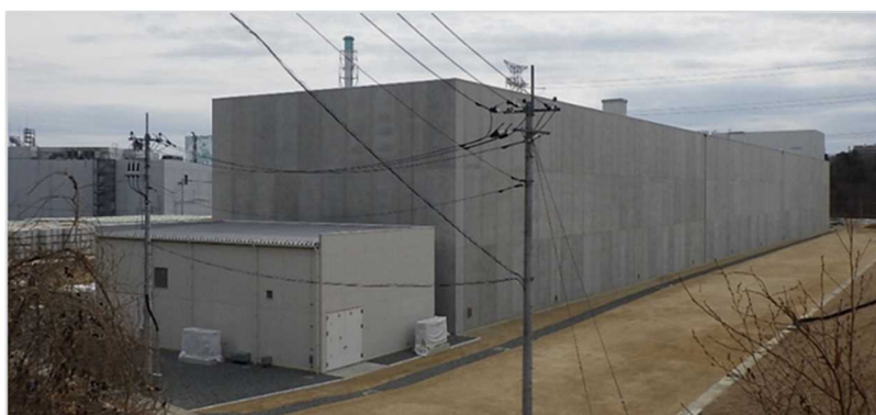
図 1-1 大型廃棄物保管庫全景（2023年2月時点）
