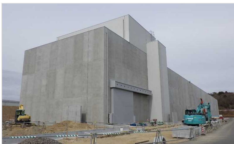
図 1-2 大型廃棄物保管庫全景（2023年2月時点）
