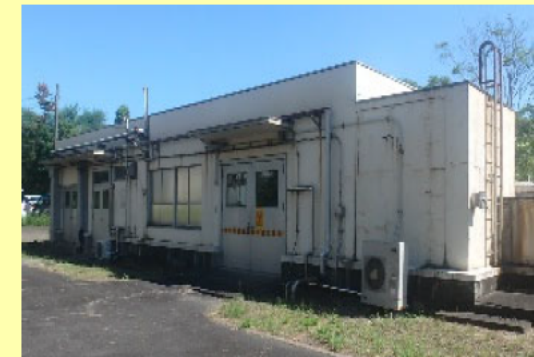
廃液長期貯蔵施設(R7~R9作業予定)
