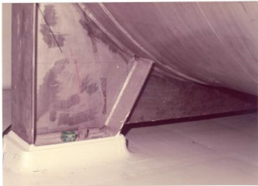
廃希釈剤貯槽（318V10）の下部
