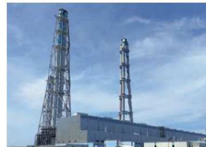
高効率のコンバインドサイクル発電方式を採用した新大分発電所
