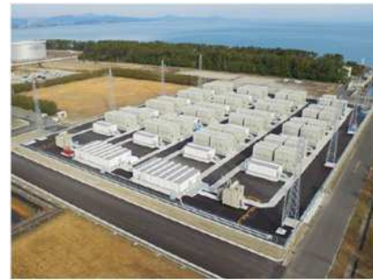
豊前蓄電池変電所（出力5万kW 容量30万kWh）
