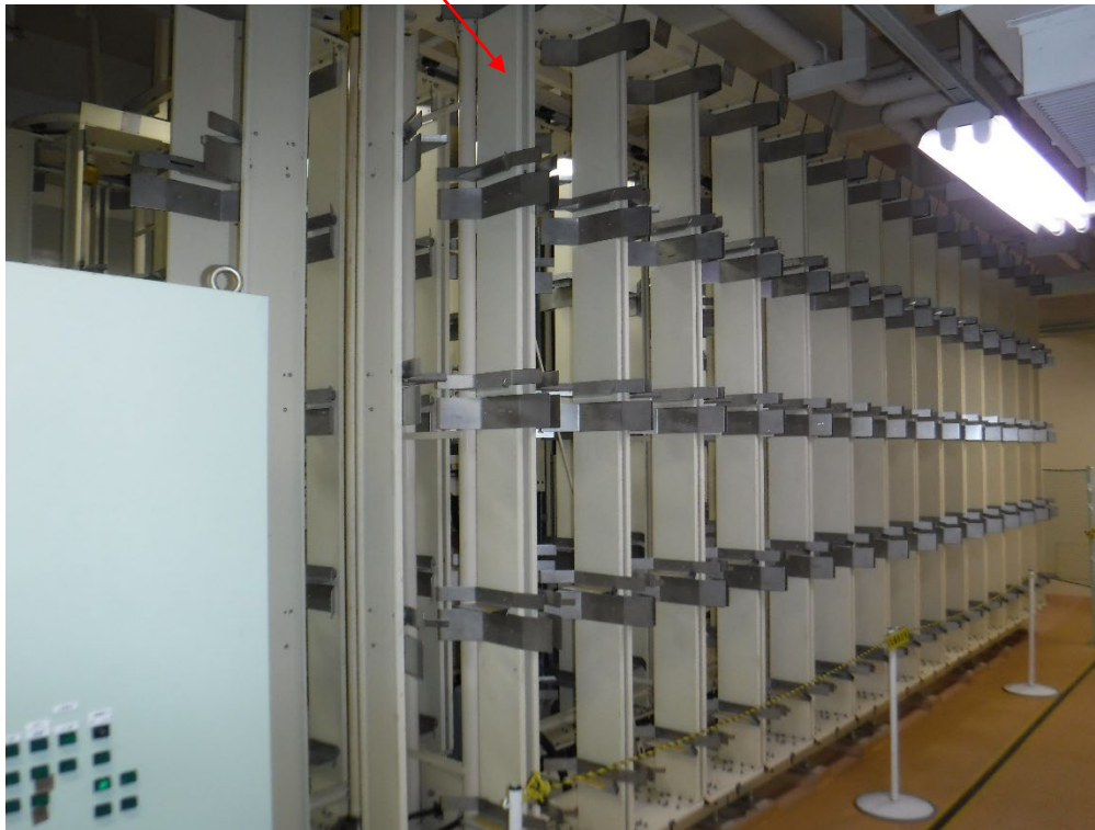
一次貯蔵ラック(342M151/M152)の設置状況
