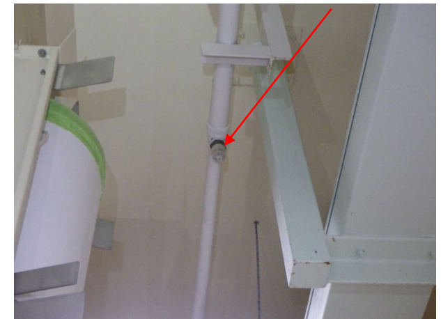
カートン貯蔵施設(A001)の天井
