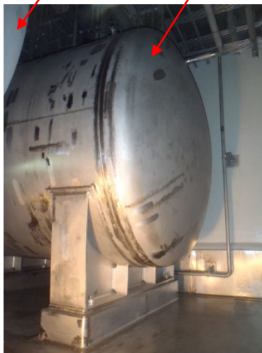
受入貯槽(328V10)の設置状況 (側面)
