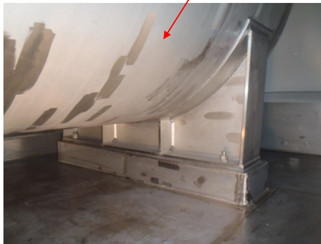
受入貯槽(328V10)の設置状況 (脚部)
