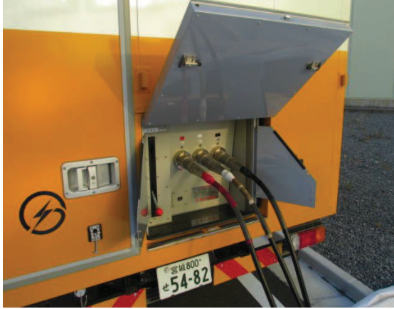
電源車ケーブル接続
