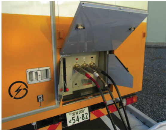
電源車ケーブル接続
