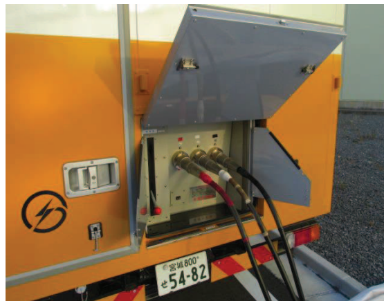
電源車ケーブル接続
