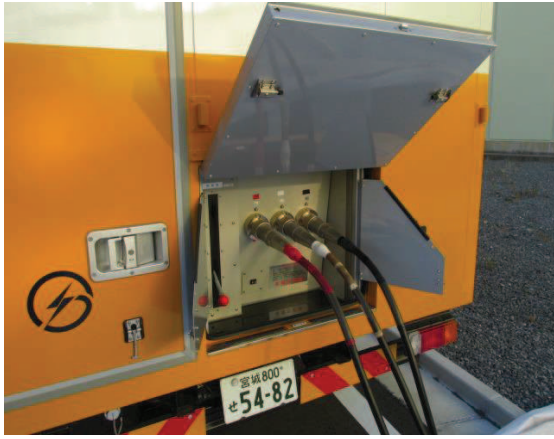
電源車ケーブル接続
