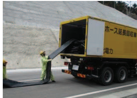
ホースの敷設、接続
