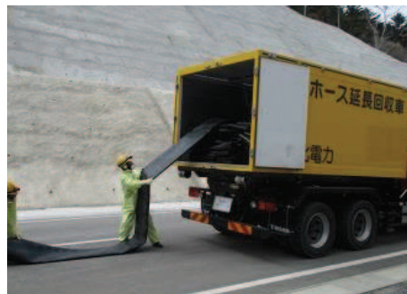
ホース敷設, 接続
