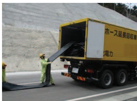
ホース敷設，接続
