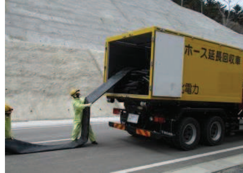
ホースの敷設，接続
