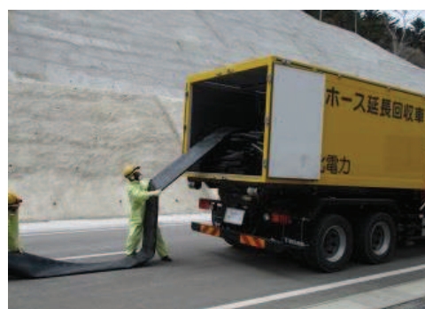
ホース敷設、接続
