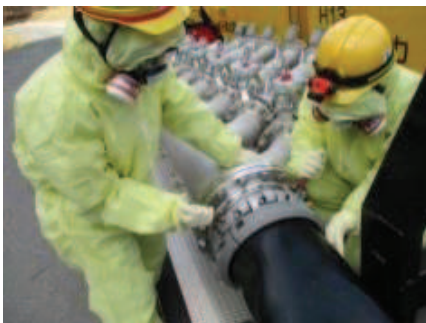
注水用ヘッダへのホース接続
