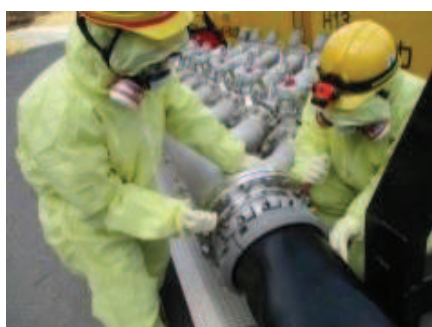
注水用ヘッダへのホース接続
