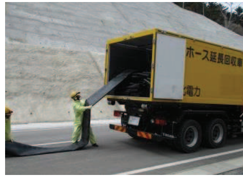
ホース敷設, 接続 (屋外)
