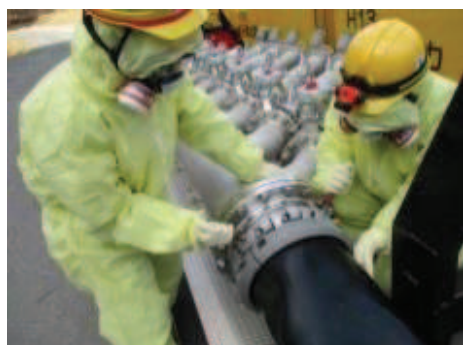
注水用ヘッダへのホース接続
