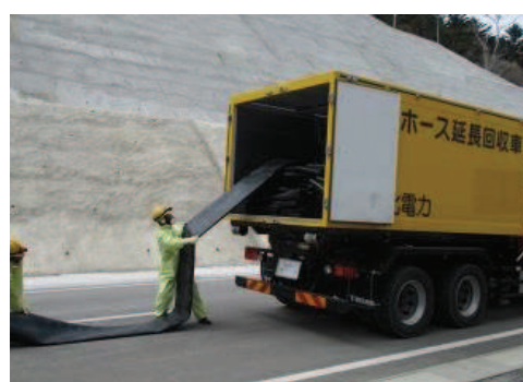
ホース敷設, 接続
