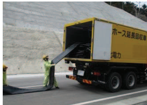
ホース敷設，接続
