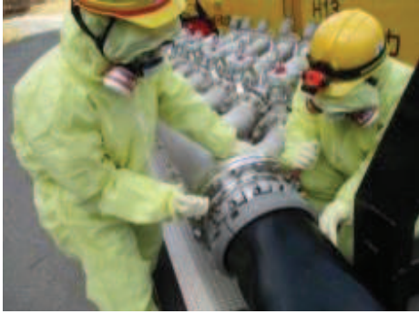
注水用ヘッダへのホース接続
