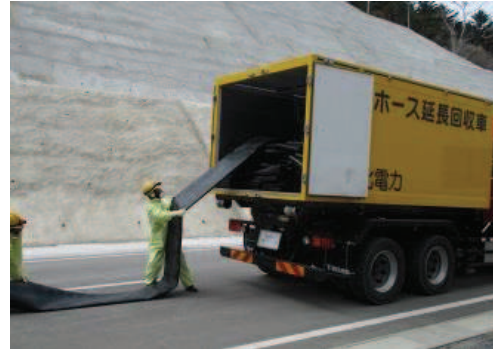
ホースの敷設, 接続
