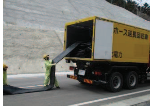
ホースの敷設，接続
