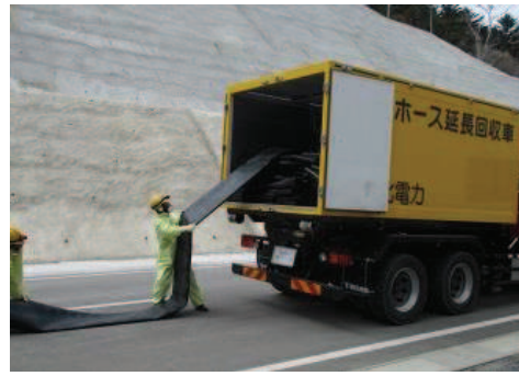
ホース敷設, 接続 (屋外)
