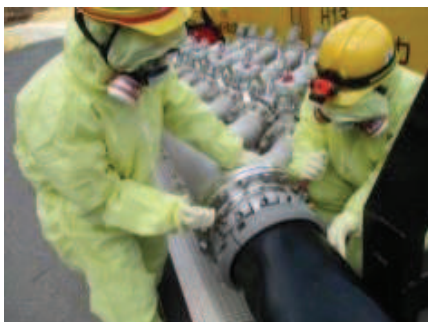
注水用ヘッダへのホース接続
