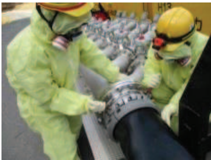
注水用ヘッダへのホース接続
