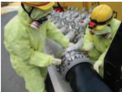
注水用ヘッダへのホース接続
