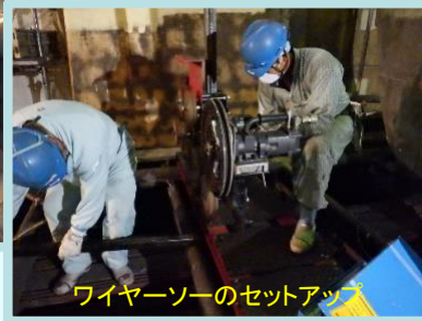
ワイヤーソーを使った冷却管群の一括切断 (2017.8.7)
