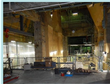
復水器解体撤去後 (2018.3.23)
