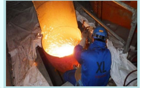
高圧タービン排気配管の切断 (2017.6.23)
