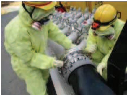
注水用ヘッダへのホース接続
