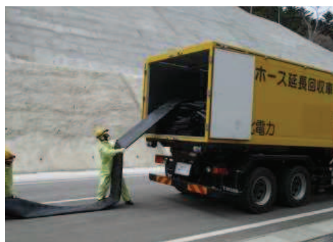
ホース敷設, 接続 (屋外)
