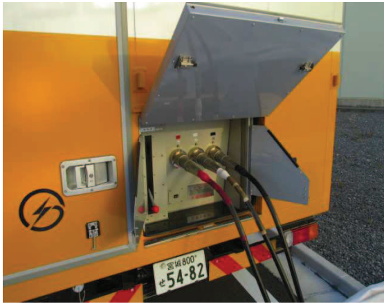
電源車ケーブル接続
