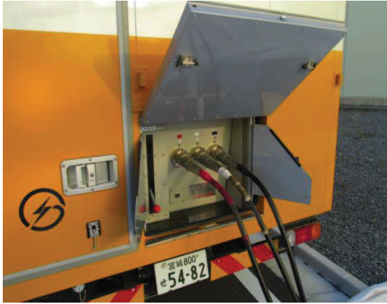
電源車ケーブル接続
