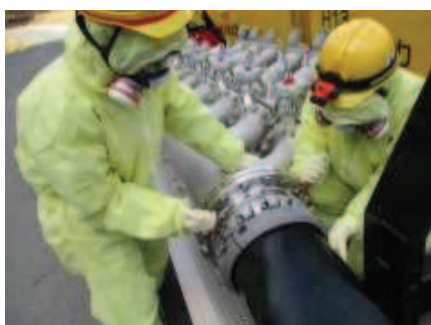
注水用ヘッダへのホース接続
