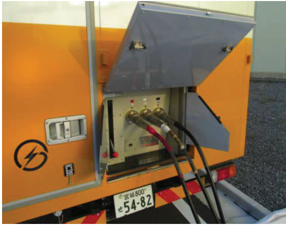
電源車ケーブル接続
