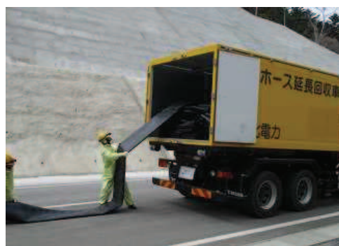
ホース敷設，接続
