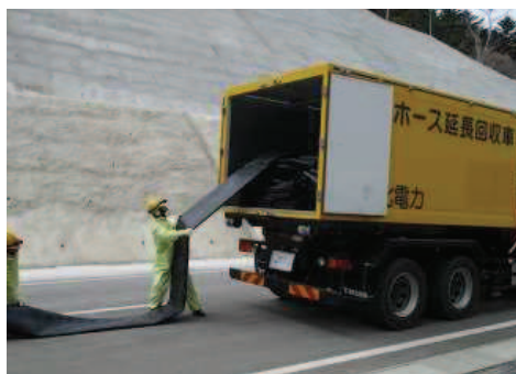
ホース敷設, 接続 (屋外)
