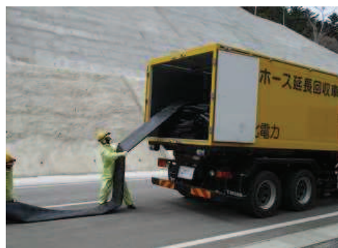
ホース敷設，接続
