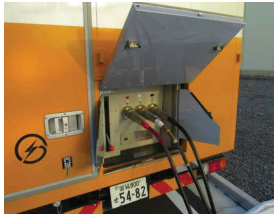
電源車ケーブル接続
