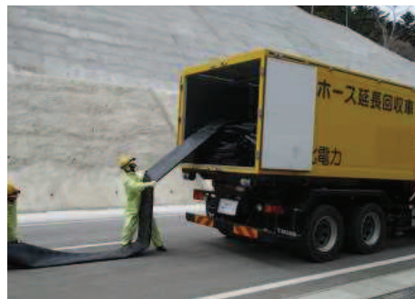
ホース敷設，接続
