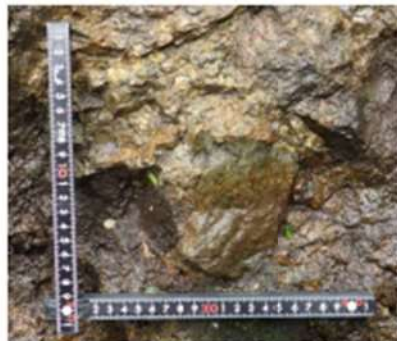
P5 防災科研調査において地滑り土塊末端部とされる箇所付近の沢の露岩状況 堅硬な岩盤（凝灰角礫岩）が認められる。
