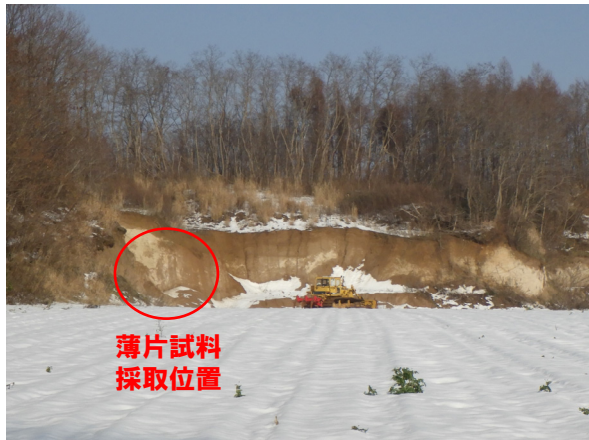
露頭①全景(令和3年11月撮影) (底盤標高:約20m, 上面標高:約35m)
