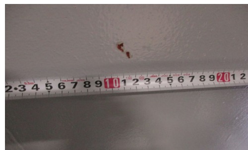
フロー②と判断した塗膜の劣化
