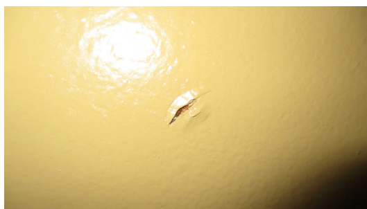
フロー②と判断した塗膜の劣化
