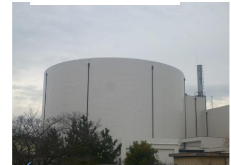
原子炉格納施設外観
