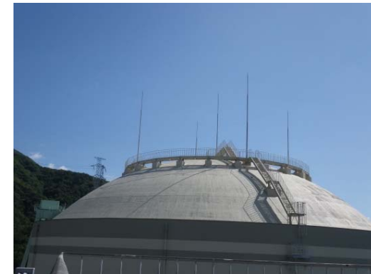
避雷針の設置 (原子炉建物屋上の例)
