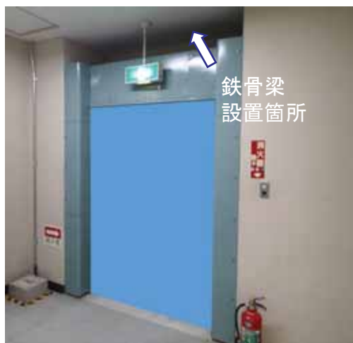
鉄骨梁補強箇所の状況 (浸水防止扉)
