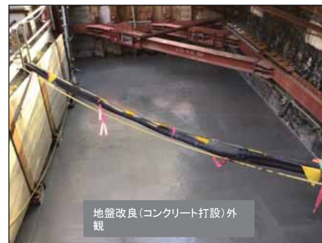
地盤改良工事の状況(令和3年12月)
