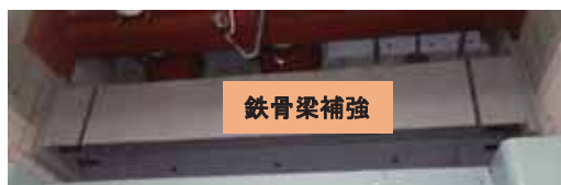
鉄骨梁補強箇所(天井パネル内)
