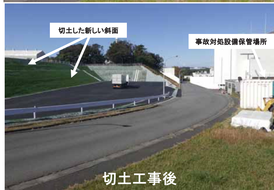
切土工事完成状況
