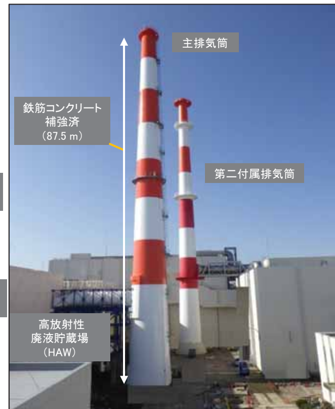
主排気筒の筒身補強工事の状況 (令和5年3月)
