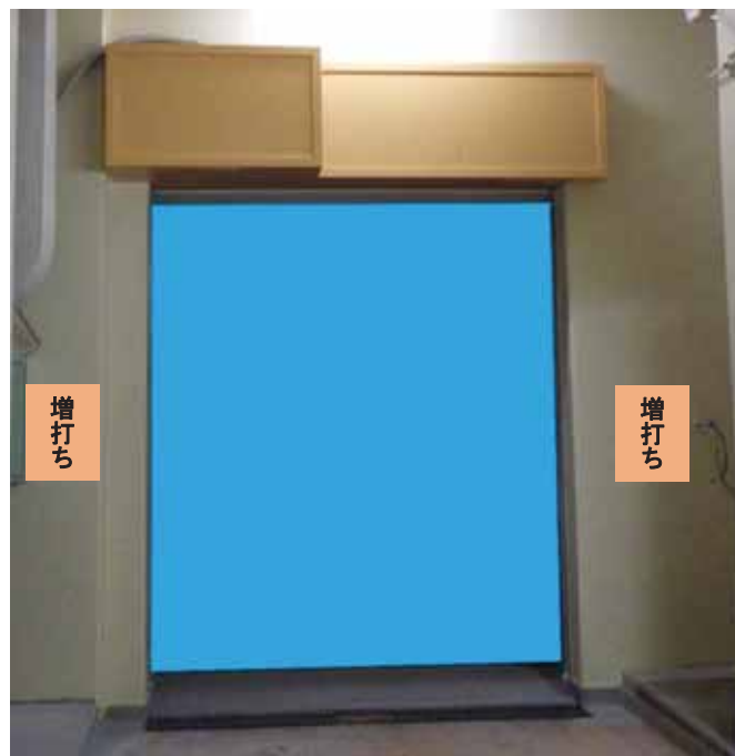
建家内開口部周辺の増打ち状況 (令和3年12月)
