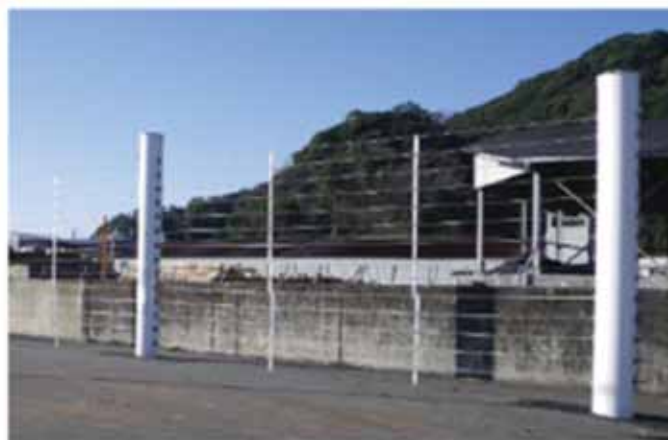
津波漂流物防護柵の設置イメージ
