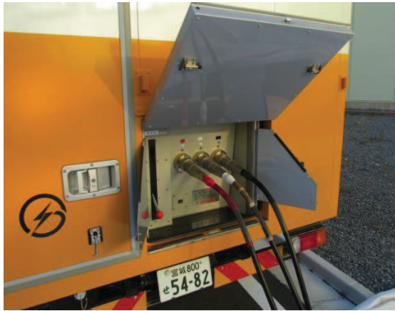
電源車ケーブル接続
