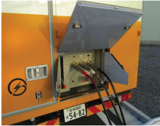
電源車ケーブル接続
