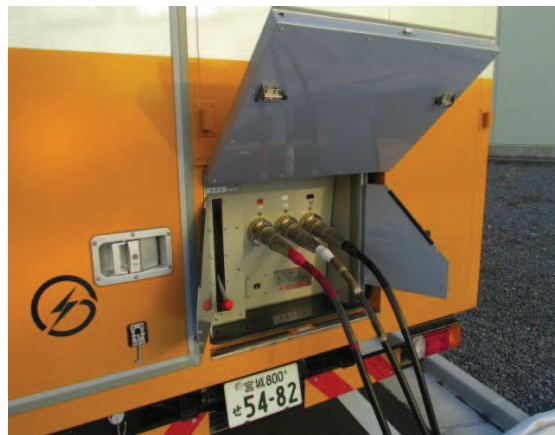
電源車ケーブル接続
