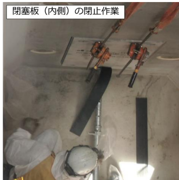
図 2.14.1-5 閉塞板による閉止状況
