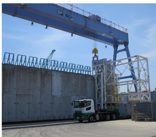
(第三施設北面 吊上げシャフト外観)
