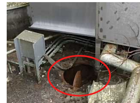
サンプ南東部のマンホール
