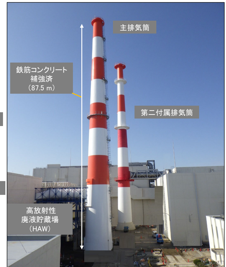
主排気筒の筒身補強工事の状況 (令和5年3月)
