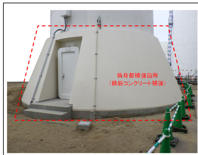
図1 第二付属排気筒の耐震補強
