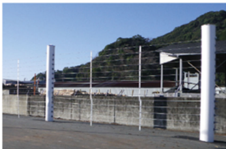
津波漂流物防護柵の設置イメージ
