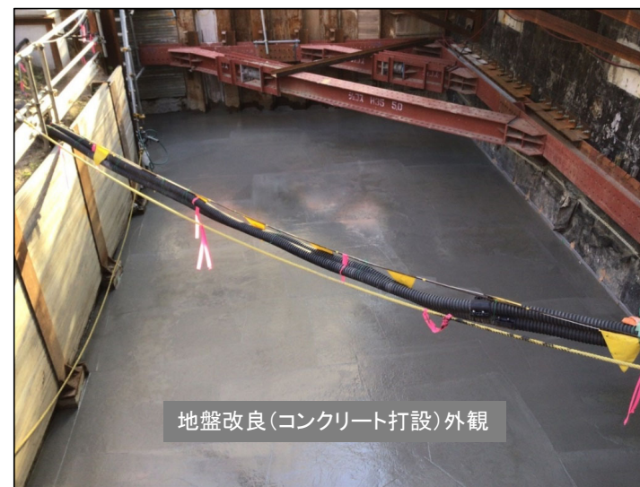
地盤改良工事の状況(令和3年12月)
