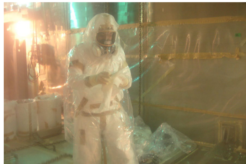
除染セル(直接保守セル)内作業時の装備
