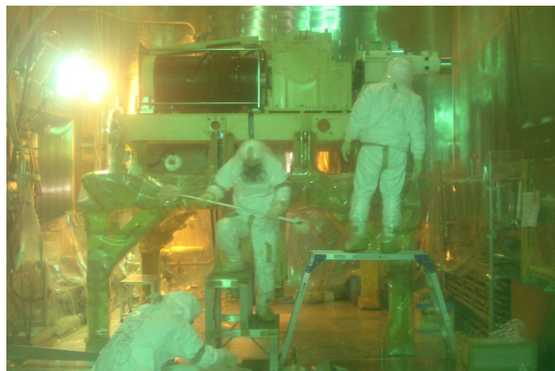
除染セル(直接保守セル)内作業状況
