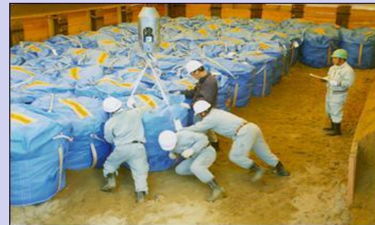
フレキシブルコンテナ収納廃棄物の定置作業状況
