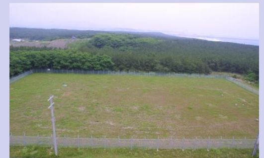
廃棄物埋設地(保全段階)
