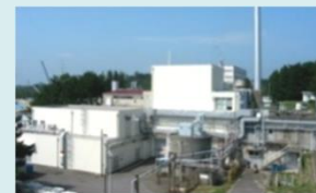
再処理特別研究棟
