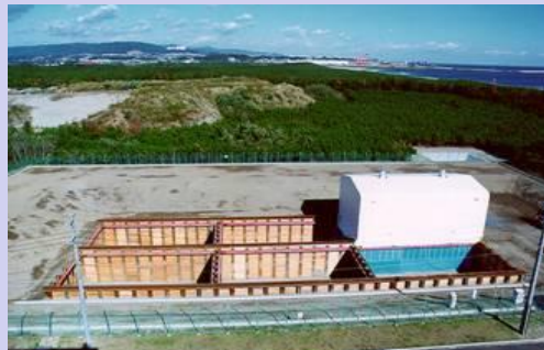
廃棄物埋設用トレンチ外観及び雨水浸入防止用テント(定置開始前)
