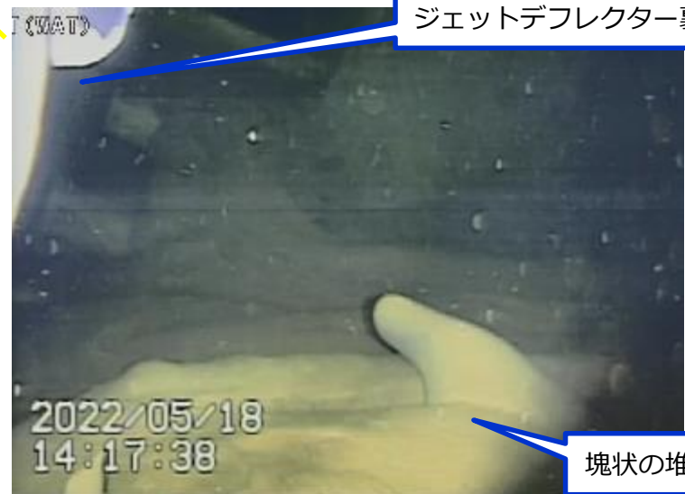
写真3.ジェットデフレクター(E)裏側の状況
