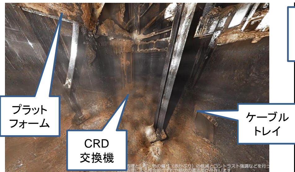
写真2. 2号機のペDESTAL内の状況
