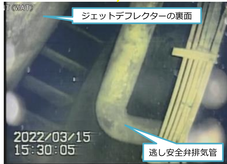
写真3.ジェットデフレクター(G)裏側の状況
