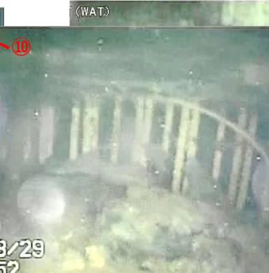
写真1. ポイント⑧ペDESTAL基礎部 画像処理：東京電力ホールディングス(株)
