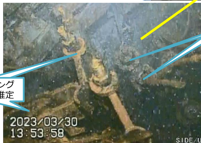
写真1. CRDハウジングサポートと思われる構造物
