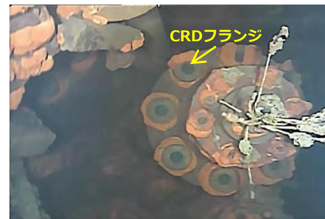
写真3. 3号機で確認されたCRD
