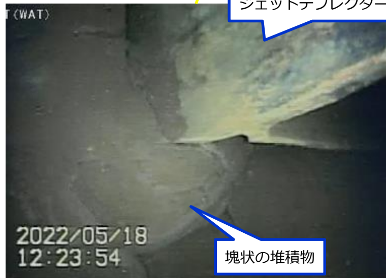
写真2.ジェットデフレクター(E)表側下部の状況
