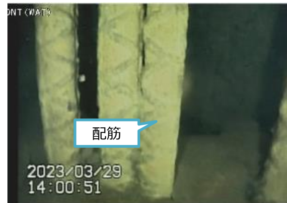
写真2. ポイント⑫ペDESTAL基礎部
