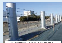
設置完了 (R5.1月撮影) 工事実績：R4.5月～R5.1月
