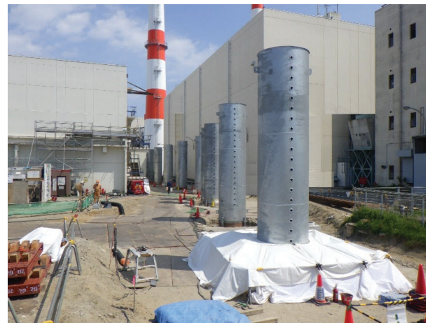
支柱建込(R5年5月撮影)
