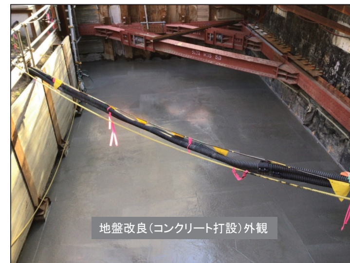
地盤改良工事の状況(令和3年12月)
