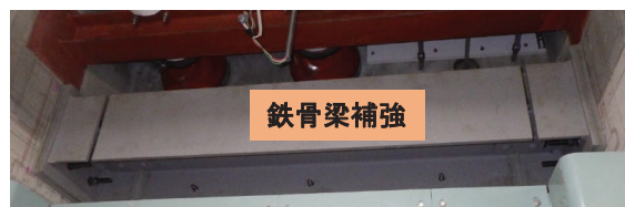
鉄骨梁補強箇所(天井パネル内)
