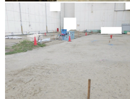
地盤改良後(R4年7月撮影)
