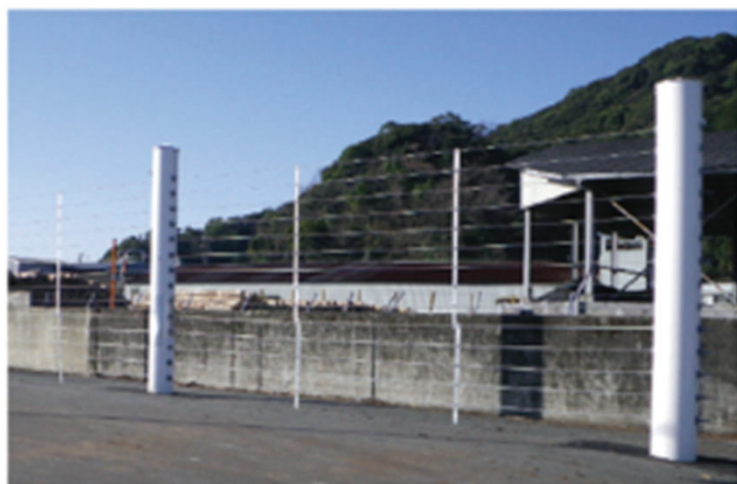
津波漂流物防護柵の設置イメージ
