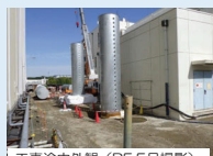
工事途中外観 (R5.5月撮影) 工事実績：R3.9月～
